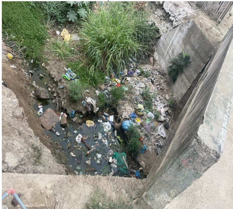
Contaminación Estero Seco – La Pila Fuente: Registro fotográfico de campo – 2023
