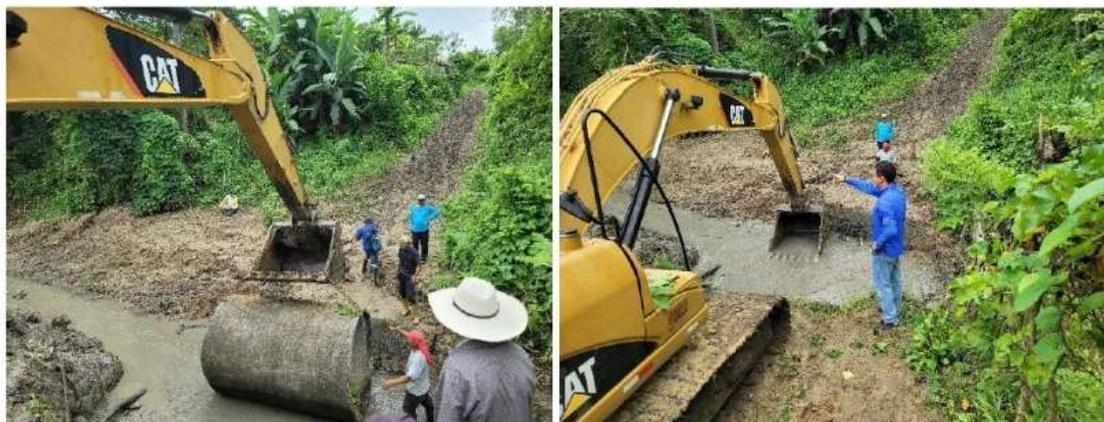
Colocación de tubos de hormigón sobre estero.
